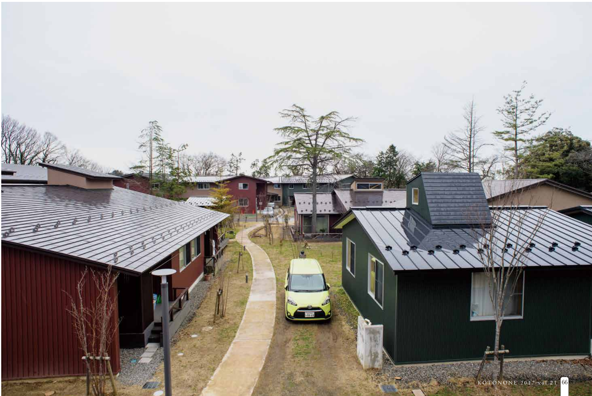
1万1000坪の敷地。電線を地下に埋設して、のびやかな空のもとに、高齢者も障害者もごちやまぜに暮らす
